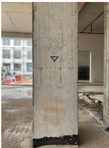
18-Сурет – Колоннаға берілетін жобалық биіктік
